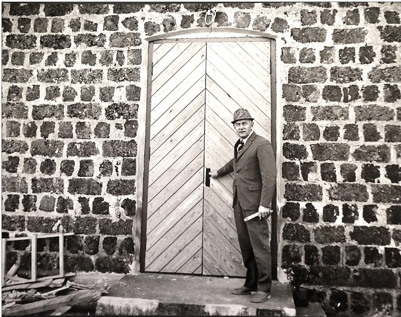
Ombyggnad pågår, Oscar Ollas på museets trappa.
