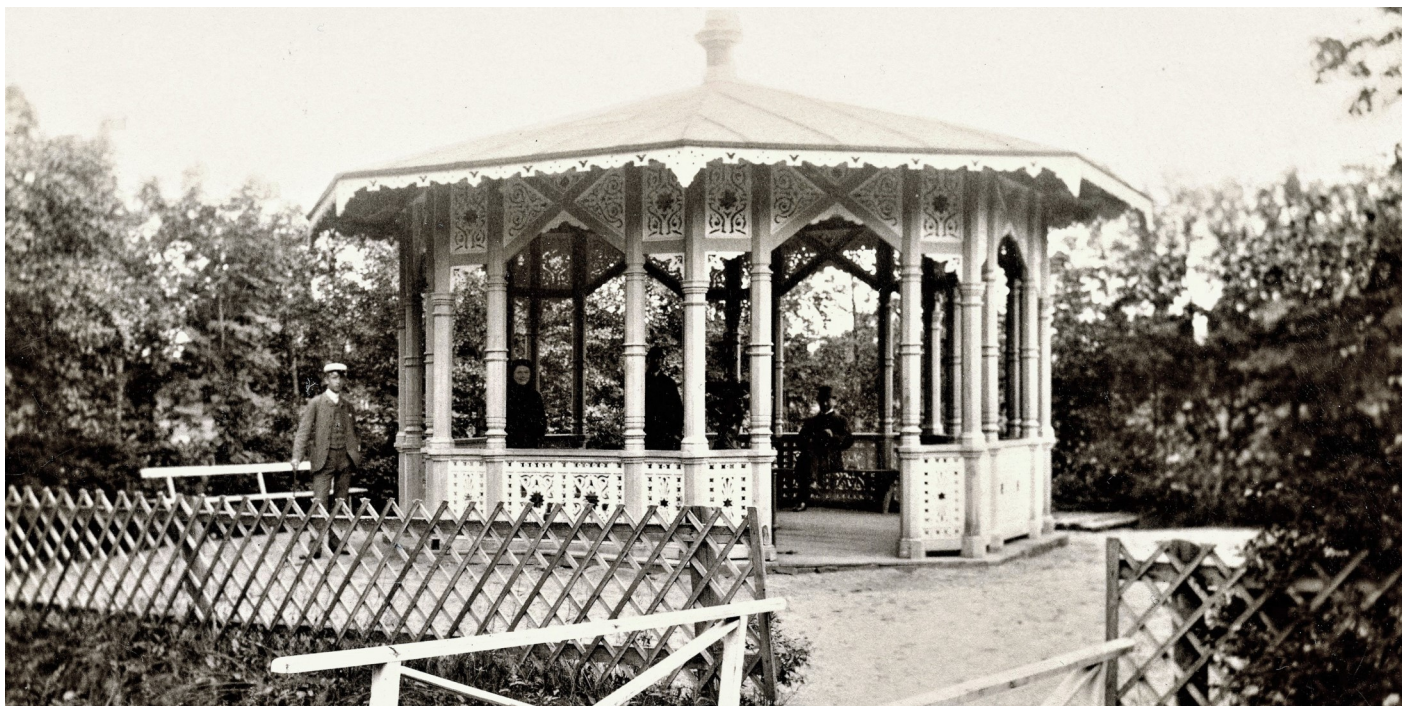
Patrikskällan upptäcktes i samband med sprängning för att anlägga en reservoar avsedd för badhuset i Porla.
